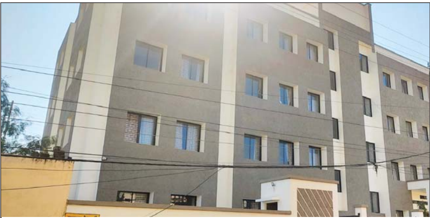
संत हिरदाराम नगर में अनेक जगहों पर हो रहा बहुमंजिला दुकानों का निर्माण
